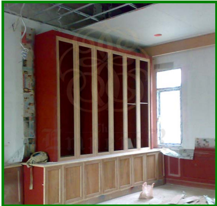
งานประกอบโครงตู้บิลด์อินและงานทำสีรองพื้น ของงานตกแต่งภายในห้องรับแขก และห้องรับประทานอาหาร
