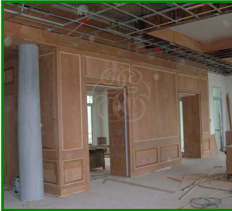
งานกรุปิดแผ่นไม้อัดและติดตั้งคิ้วไม้ประดับผนังของ Meeting room
